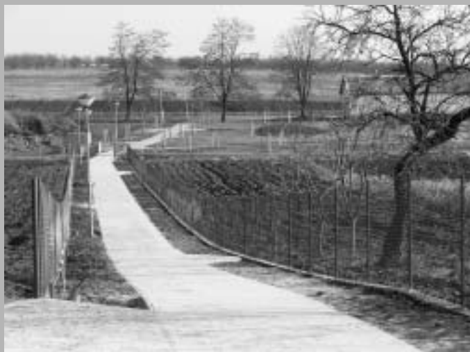
Nově zrekonstruovaný chodník k zastávce ČD. Foto: Z. Karber
